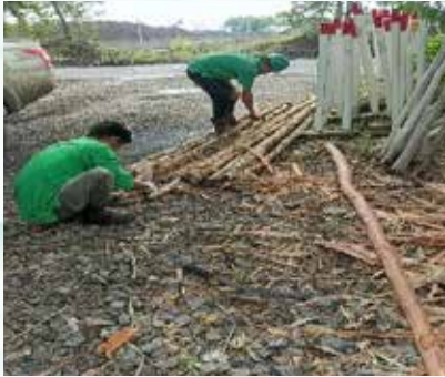
Pembuatan Mata Kucing Reflector Construction
