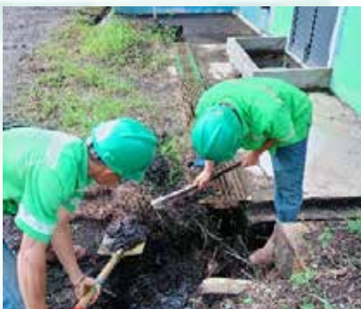
Pembersihan Saluran Sewer Cleaning
